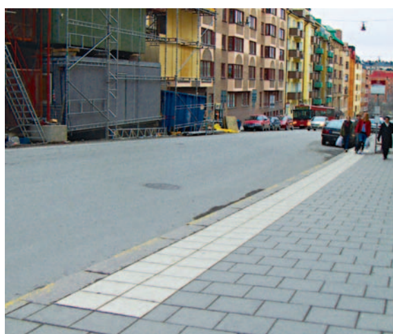
Tydlig markering vid busshållplats
